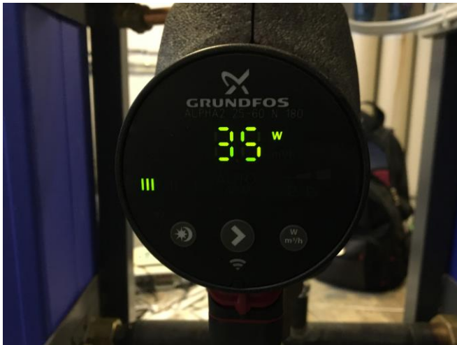
Pump med konstant varvtal. Display av effekt.
