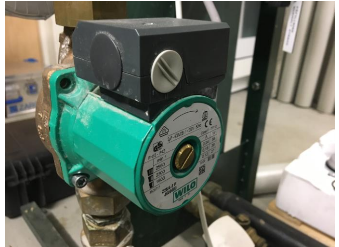
Pump med 3 fasta inställningar, 1, 2 och 3.
