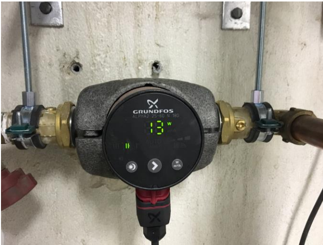
Pump med konstant varvtal. Display av effekt.
