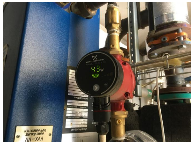
Pump med fabriksinställning, "Autoadapt".
