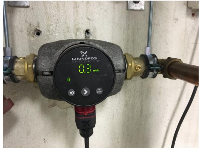
Pump med konstant varvtal. Display av flöde.
