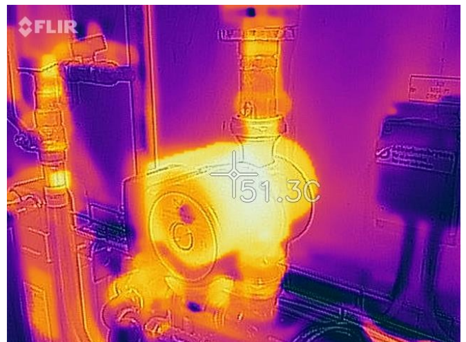
Värmebild av pump med 1 fast inställning, on/off.
