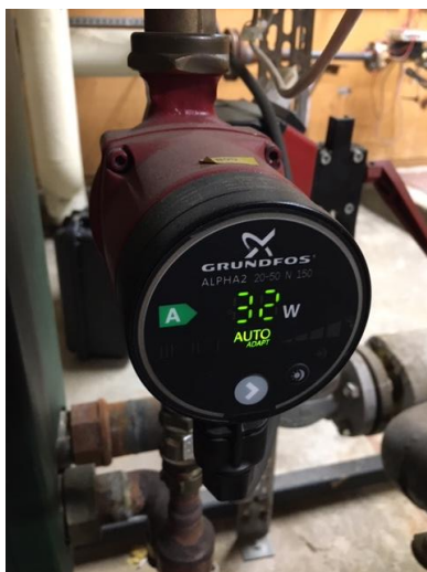
Pump med fabriksinställning, "Autoadapt".
