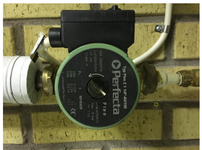
Pump med 3 fasta inställningar, 1, 2 och 3.
