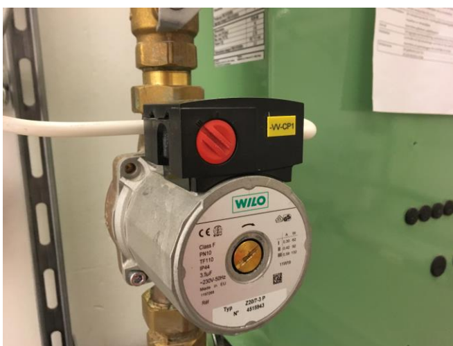
Pump med 3 fasta inställningar, 1, 2 och 3.
