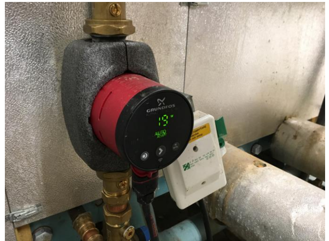
Pump med fabriksinställning, "Autoadapt".
